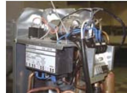
Фото 6. Так выглядит полностью смонтированный регулятор
