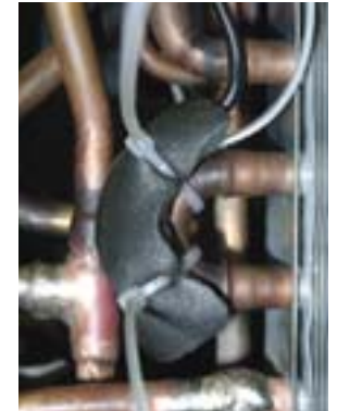
Фото 5. Дополнительная теплоизоляция повышает точность показаний сенсора
