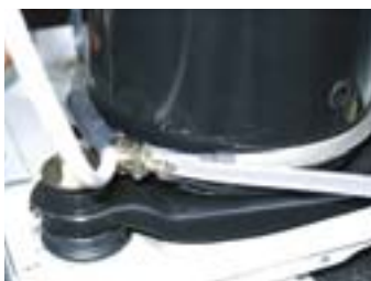
Установленный картерный нагреватель
